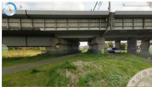
土木構造物保守
