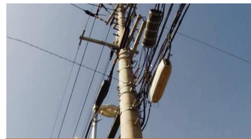
電気設備保守
